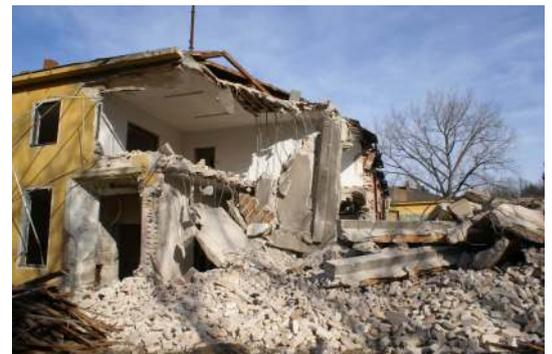
Bei den abzubrechenden Gebäuden handelte es sich in der Mehrheit um ein- bis zweigeschossige Ziegelbauten aus den 30-er Jahren des vorigen Jahrhunderts. Diese wurden bereits als Bestandteil des Truppenlagers errichtet. Hinzu kamen mehrere fünfgeschossige Plattenbauten, die um 1980 errichtet wurden.
